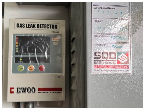
ภาพที่ 2-4 Gas Detector
